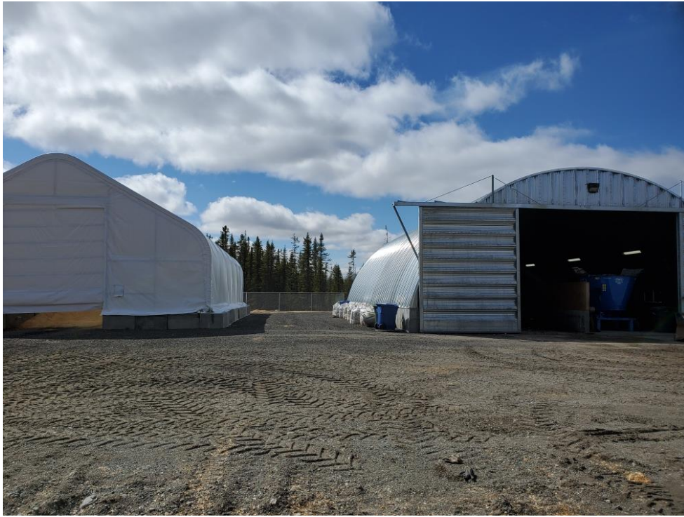
Figure 1 : Bâtiments abritant les installations de compostage de la Municipalité de Landrienne
