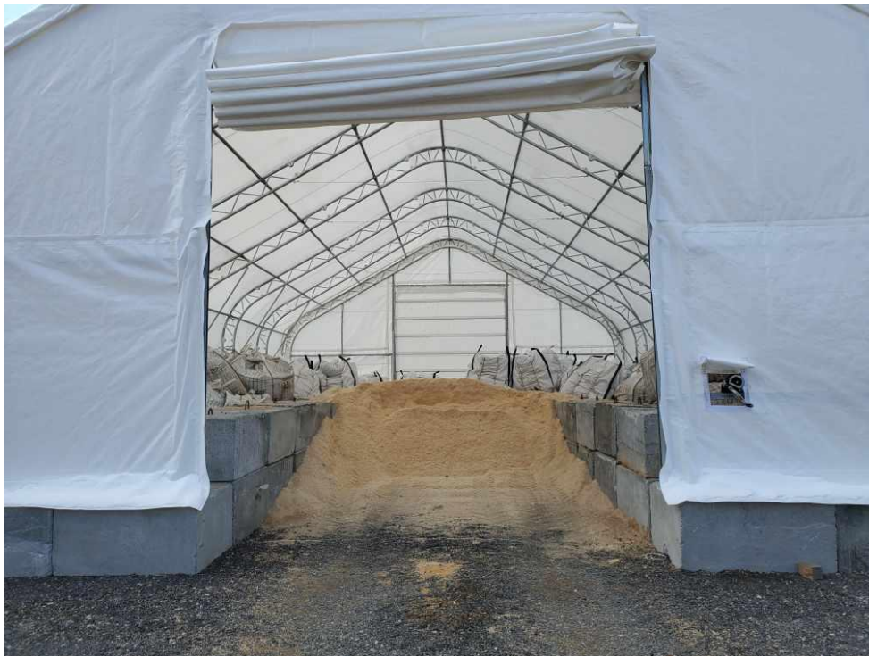
Figure 4 : Intérieur de l'abri pour l'entreposage du structurant et la maturation du compost
