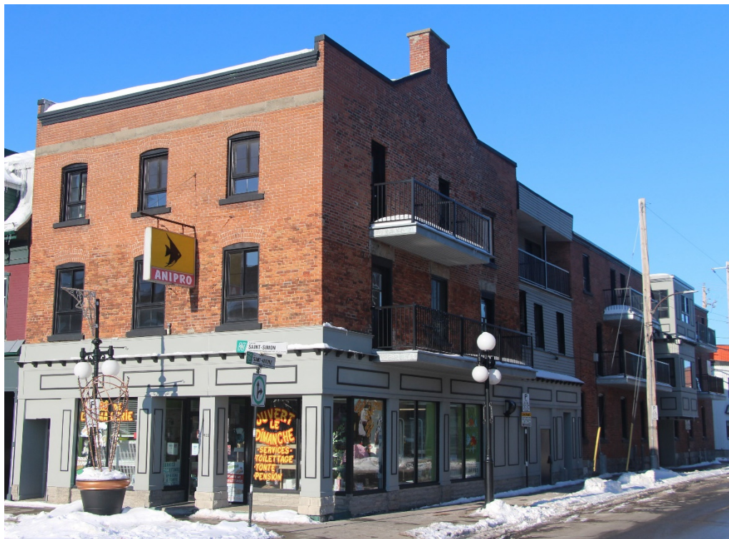
Immeuble acquis par la Ville de Saint-Hyacinthe en prévision de la réalisation du projet « 1400 saint-Antoine », © 2021, David Bousquet
